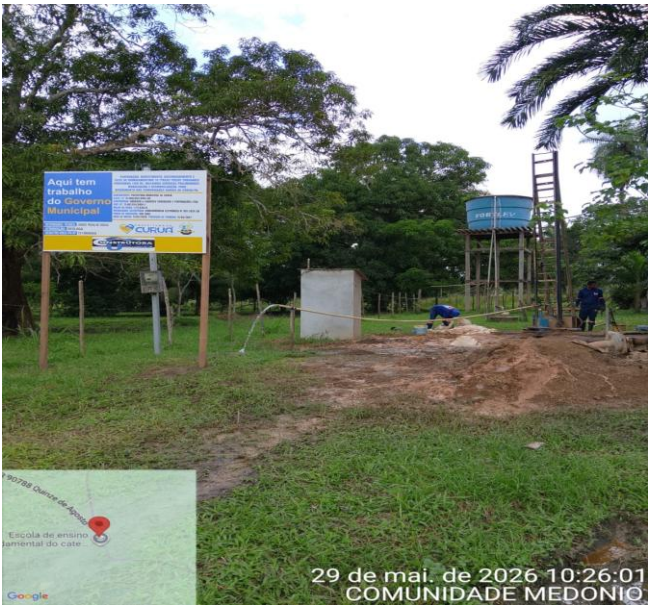
FOTO 12: Placa de identificação da obra (Governo Municipal) e poço com fluxo de água ao fundo. Comunidade Medonio, 29/05/2026 10h26.
