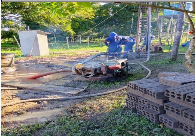
FOTO 09: Motobomba de circulação de fluido em operação — tijolos/blocos cerâmicos estocados ao lado. Comunidade Medonio.
