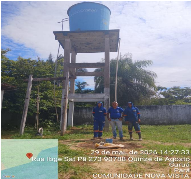
FOTO 11: Caixa d'água elevada concluída, com equipe técnica. Comunidade Nova Vista, 29/05/2026 14h27.
