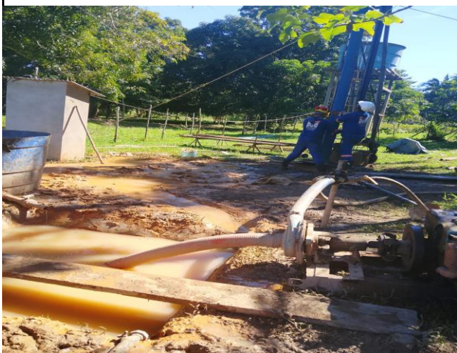
FOTO 05: Equipe operando a sonda perfuratriz — bomba de lama em primeiro plano. Comunidade Medonio.
