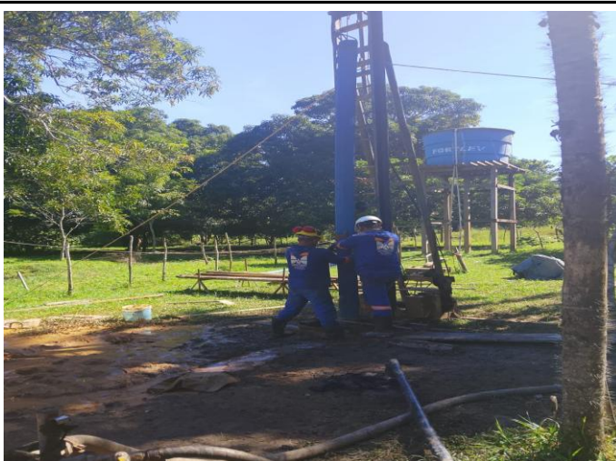
FOTO 08: Equipe posicionando tubo de revestimento na coluna de perfuração. Comunidade Medonio.
