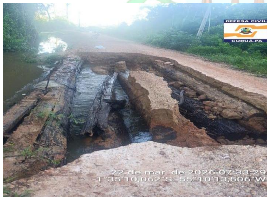
Foto 01: vista frontal da pinguela existente — Comunidade Maloca 02 (22/03/2026, 1°35'10,062"S 55°10'13,506"O)
