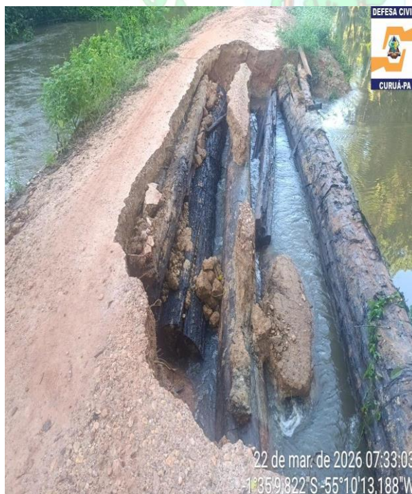
Foto 04: vista da passagem sobre o curso d'água — Comunidade Maloca 02 (22/03/2026, 1°35'9,822"S 55°10'13,188"O)
