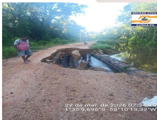
Foto 02: vista frontal da passagem — Comunidade Maloca 02 (22/03/2026, 1°35'9,696"S 55°10'13,32"O)
