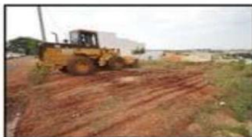
Limpeza do Terreno
