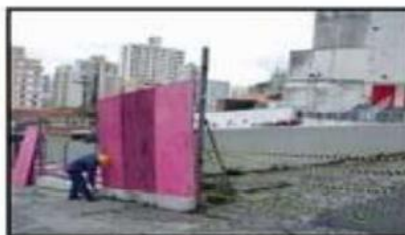
Fixação dos Tapumes
