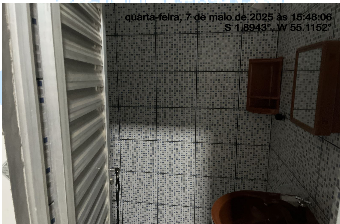
Foto própria 15: banheiro recepção.
