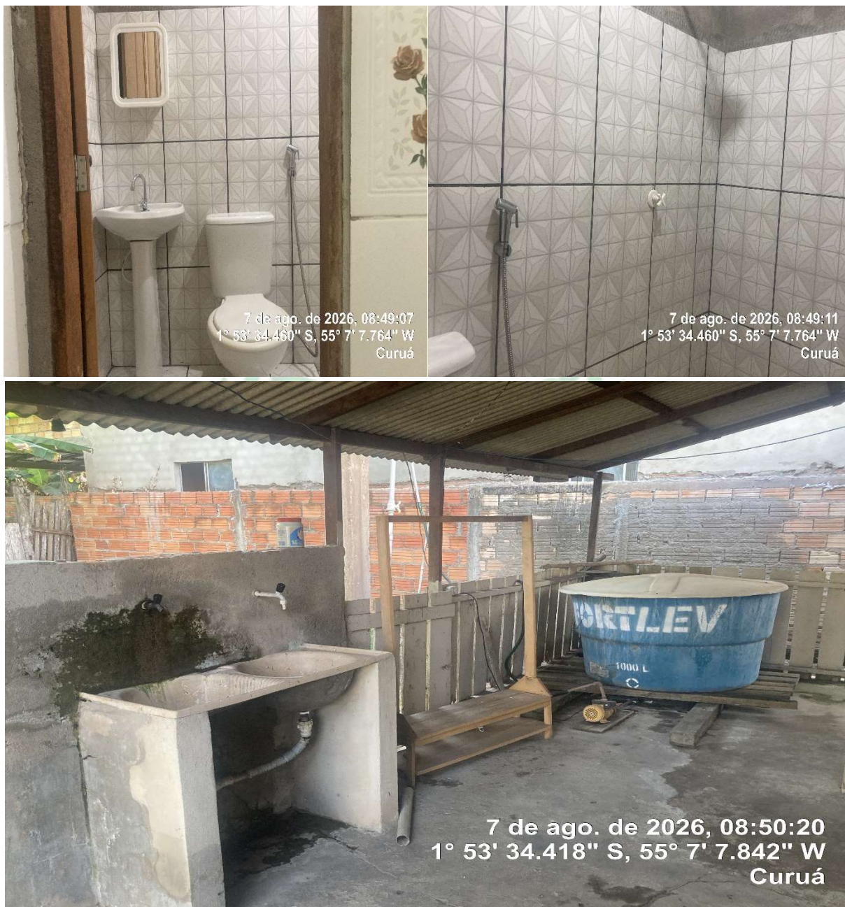
Imagens 14,15 e 16 Banheiro Social e Área de Serviço
