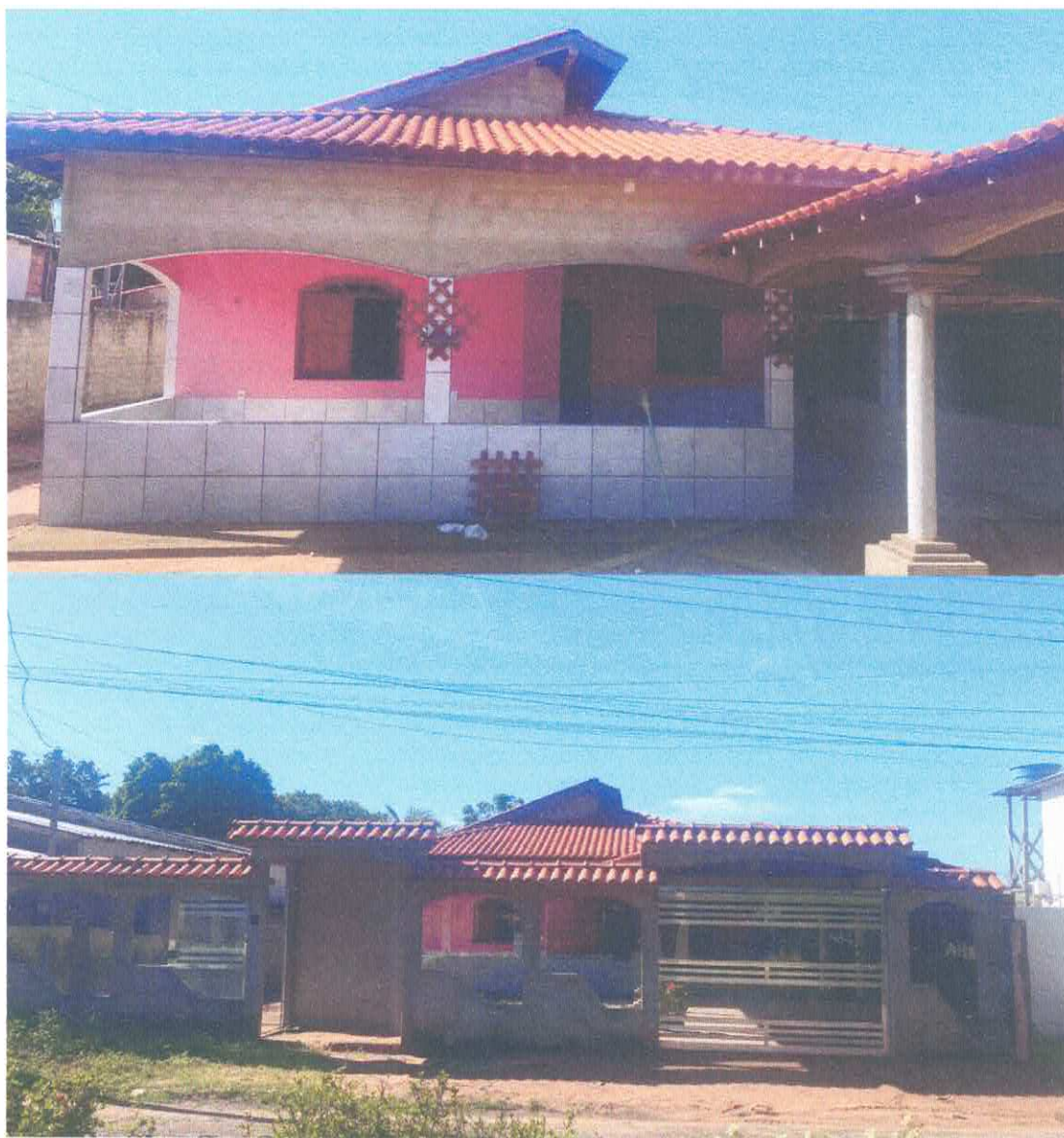
Imagens 1 e 2 Fachada Principal
