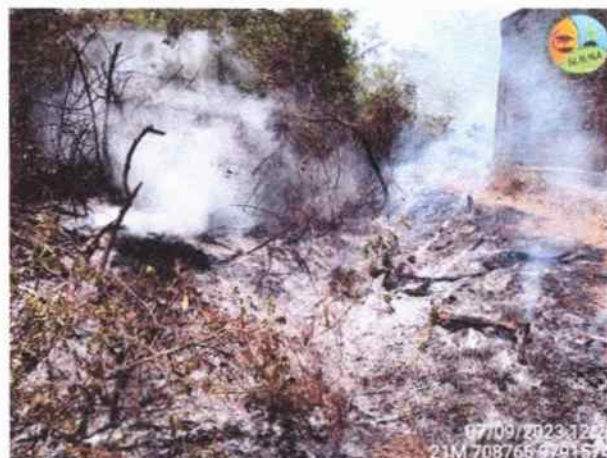
Foto 02: Foco de incêndio próximo a subestação do município.
