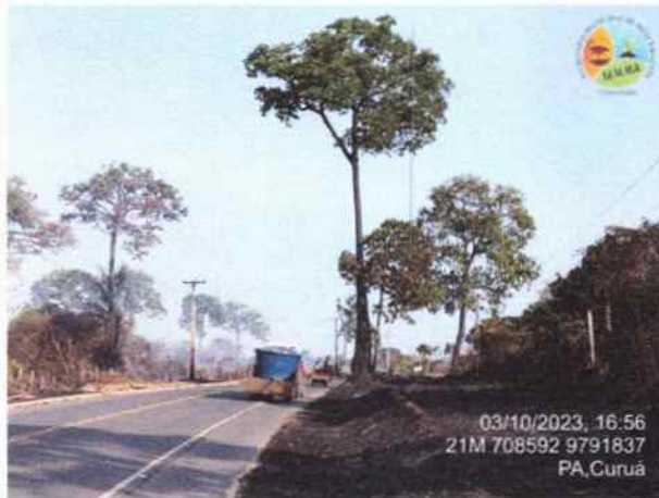
Foto 05: Combate a incêndio próximo a rede de distribuição elétrica do município.
